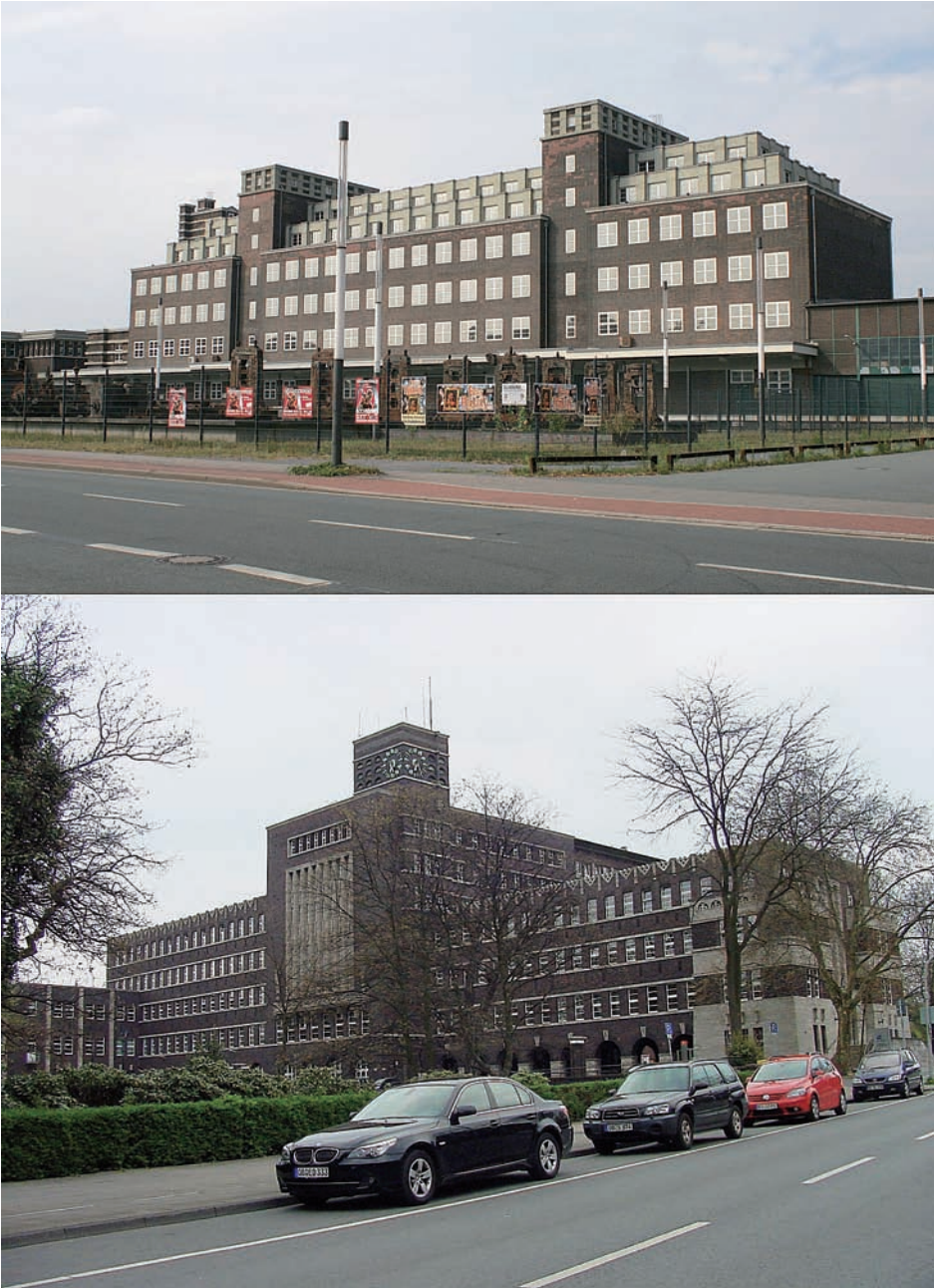
Abb. 14: Das Hauptlagerhaus der GHH aus den 1920er Jahren, besteht zum Schutz vor Bergschäden aus einem aufwändigen Stahlskelettbau, der architektonisch sehr hochwertig ausgeführt wurde. Heute gehört es als Depot-Gebäude zum LVR-Industriemuseum (Bild oben). Das Rathaus stammt wie der Bahnhof aus den 1930er Jahren und repräsentierte die damals aufstrebende GHH-Stadt mit anspruchsvoller Zweckarchitektur, die praktisch unverändert erhalten geblieben ist (Bild unten)
