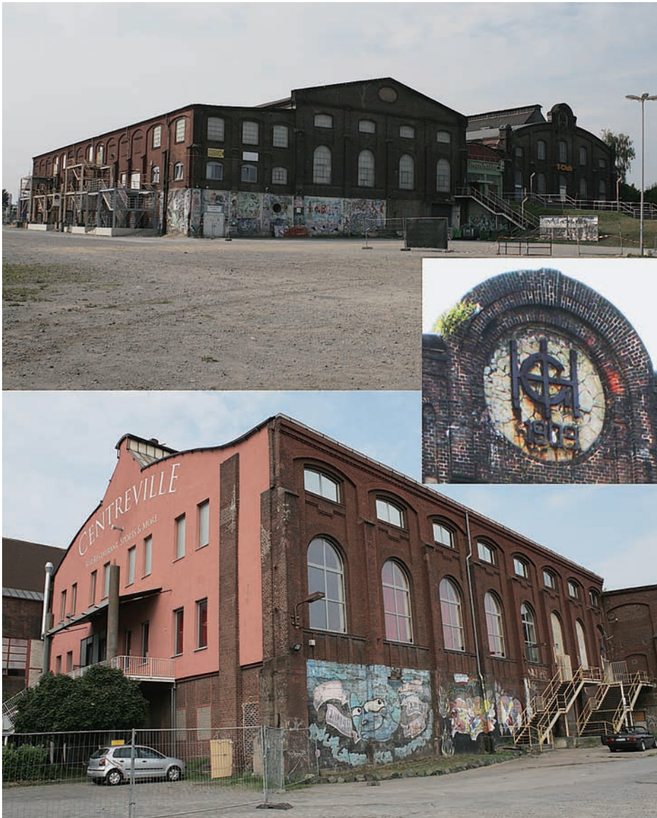
Abb. 12: Die ehemaligen Turbinenhallen befinden sich heute in schlechtem Gebäudezustand. Sie werden mit geringstem Erhaltungsaufwand als Diskotheken genutzt. Noch findet sich am Giebel das GHH-Symbol mit der Jahreszahl 1909 (kleines Bild mitte)
