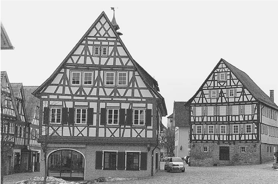
Abb. 10: Die Vogtei (rechts) ist mit zwei Fachwerkstöcken und Giebel aus dem Jahr 1604 auf dem steinernen Erdgeschoss von 1394 das mächtigste Fachwerkhause in Neubulach, und bildete im frühen 17. Jahrhundert mit der nördlich (rechts) gelegenen, heute aber nicht mehr bestehenden Scheune ein großes Anwesen im Besitz der vermögenden Familie Essig. Erst im späten 17. oder frühen 18. Jahrhundert wurde es von der Herrschaft als Vogtei angekauft. Das Alte Rathaus (links) wurde mehrfach umgebaut, der Giebel stammt wohl aus dem 17. Jahrhundert Foto: Meyerdirks, 2010
