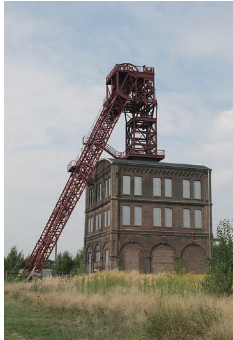
Abb. 18: Schacht 1 der Zeche Sterkrade hat es schlechter getroffen. Ohne die frühere Abdeckung über den beiden verbliebenen Seilscheiben und die zugehörige Bühne steht das Schachtgerüst inmitten einer bauschutt- und unkrautübersäten Industriebrache. Das unter dem Schachtgerüst befindliche Schachtgebäude ist rudimentär erhalten
