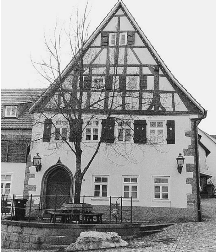
Abb. 7: Das Haus Obere Torstraße 3 (Nr. 82) weist zwei massive Steingeschosse von 1392/93 mit Spitzbogenportal auf, die einen 1507 errichteten Dachstuhl tragen Foto: Meyerdirks 2010
