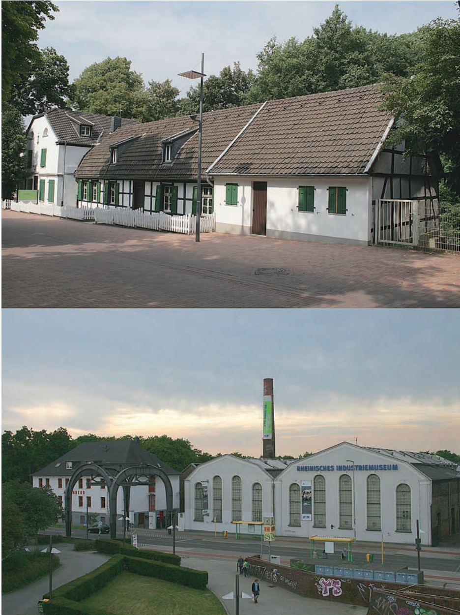
Abb. 15: Nur das industriegeschichtlich unbedeutendere Wohnhaus der Anthony-Hütte blieb erhalten, Hochofen und Fabrikgebäude wurden abgerissen (Bild oben). Die ehemalige Zinkfabrik Altenberg (Vielle Montagne) dient heute dem LVR-Industriemuseum als Ausstellungs- und Verwaltungsgebäude (Bild unten)
