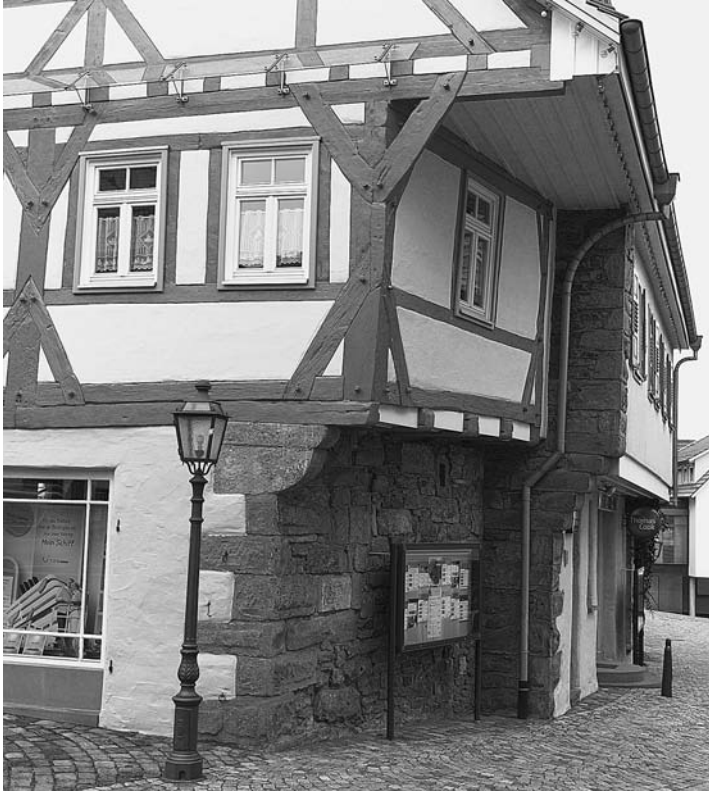
Abb. 8: Das Haus Marktstraße 2 (Nr. 86) in Neubulach besteht aus zwei Teilen, die durch eine mächtige Brandmauer getrennt sind. Das Obergeschoss kragt weit nach Süden über das steinerne Erdgeschoss mit Eckbuckelquadern aus, wobei die Brandmauer mittels fünf übereinanderliegender Kragsteine vorspringt. Das im Bild sichtbare Fachwerk der Westhälfte datiert um 1420/30, die Osthälfte um 1390/1400 Foto: Meyerdirks 2010
