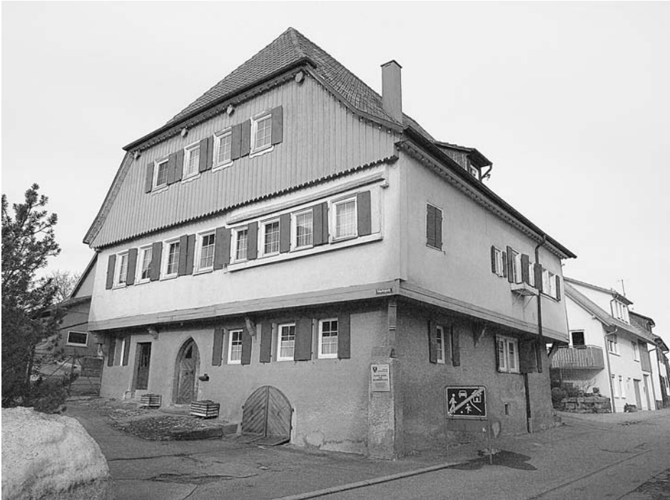
Abb. 6: Das Haus Marktplatz 5 (Nr. 29) von 1364/65 ist das älteste Gebäude innerhalb der Stadtmauer, verfügt über eine bauzeitliche Stube mit Bohlenbalkendecke im weit vorkragenden Fachwerkstock sowie ein Spitzbogenportal im Erdgeschoss und wurde 1567/68 erweitert
