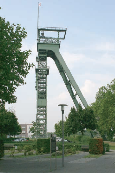
Abb. 17: Eines der beiden erhaltenen stählernen Schachtgerüste in Oberhausen: Osterfeld 3 befindet sich mit einem Teil der alten Zechengebäude in gutem Zustand auf dem Oberhausener Gartenschau Gelände
