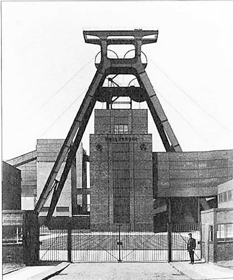
Abb. 2: Zentralschachtanlage XII, 1932 Geschichtswerkstatt Zollverein 1996, S. 56
